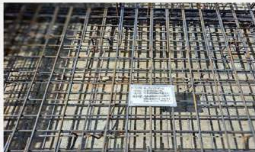
筏式基礎 版筋綁紮自主檢查
