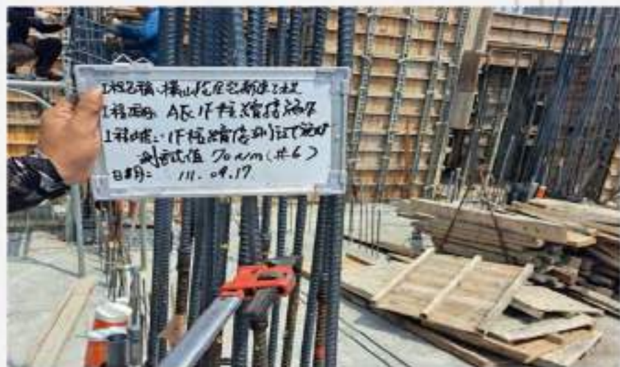
柱筋續接扭力測試 試驗自主檢查
