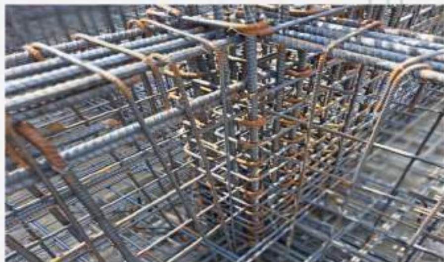
筏式基礎 地樑鋼筋
