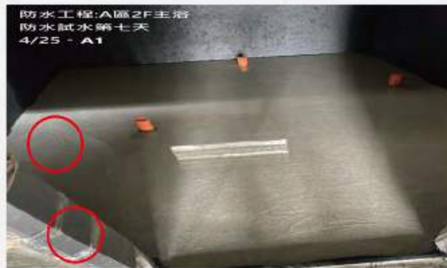
浴室防水浸水測試
