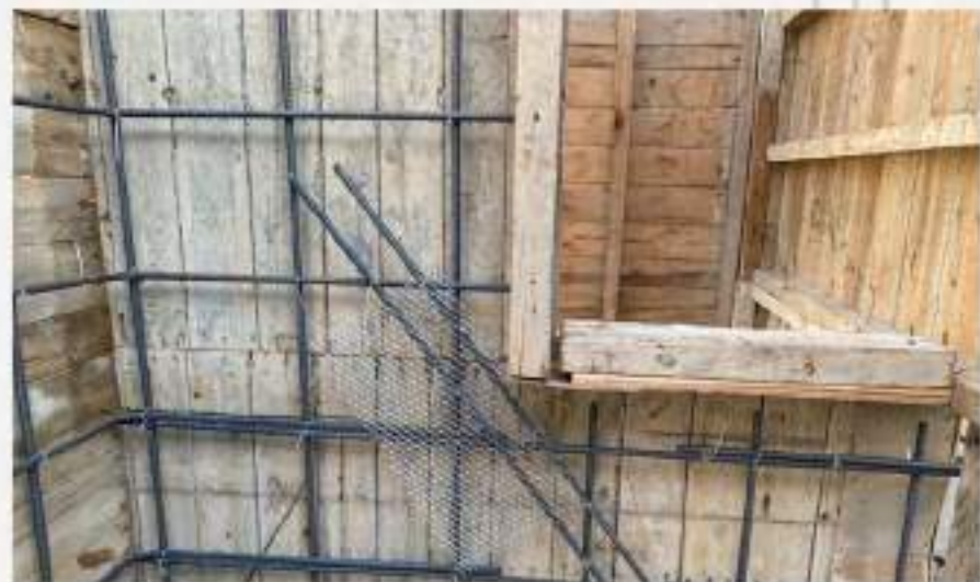
窗框斜筋加強結構。
