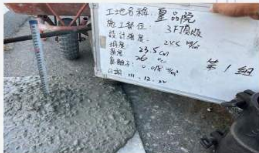
混凝土材料坍度測試 試驗自主檢查 確保材料品質
