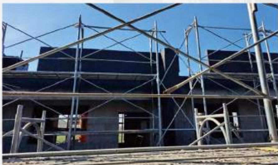
外牆打底 完成後噴塗防水彈泥施作
