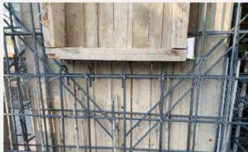
窗框斜筋加強結構。
