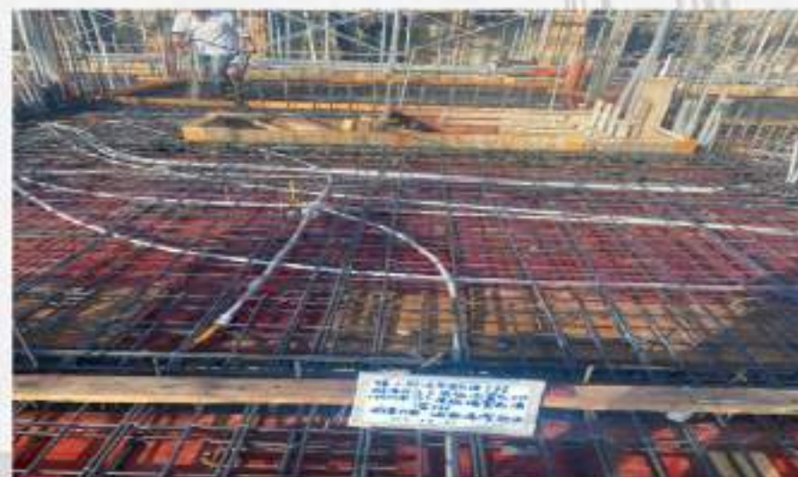
鋼筋綁紮完成後版面 清洗確保施工品質
