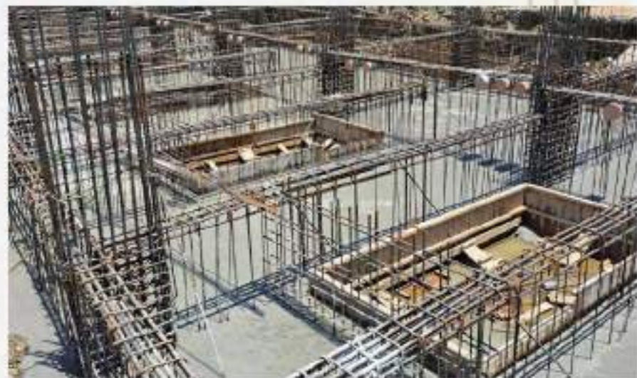
基礎工程澆置完成
