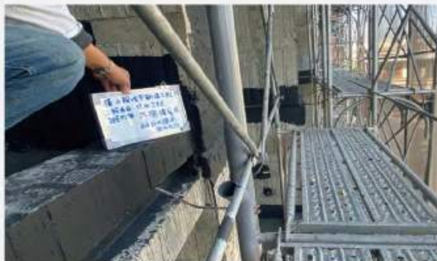
樓層二次接縫 防水彈泥施作防止 外牆滲水至室內地坪
