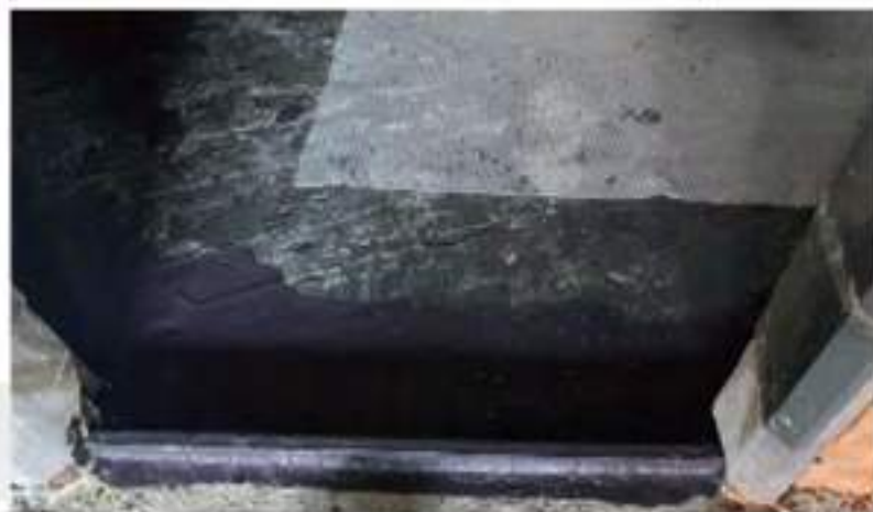
5. 彈泥第一度, 鋪抗裂網
