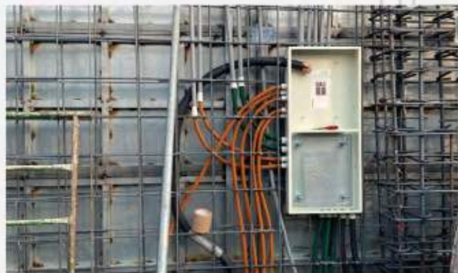
水電配管落實。
