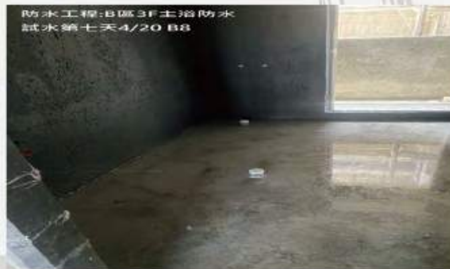
浴室防水浸水測試
