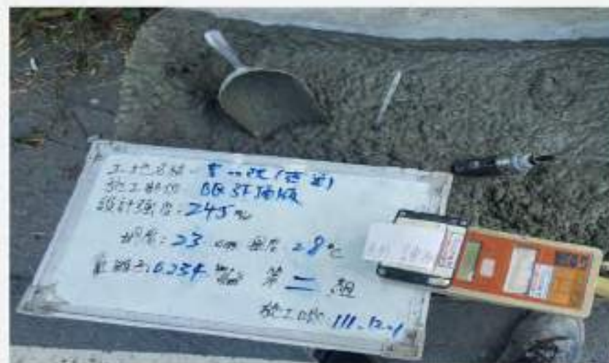
混凝土材料氯離子測試 試驗自主檢查 確保材料品質
