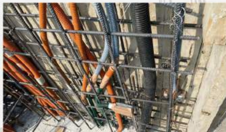
水電配管落實。
