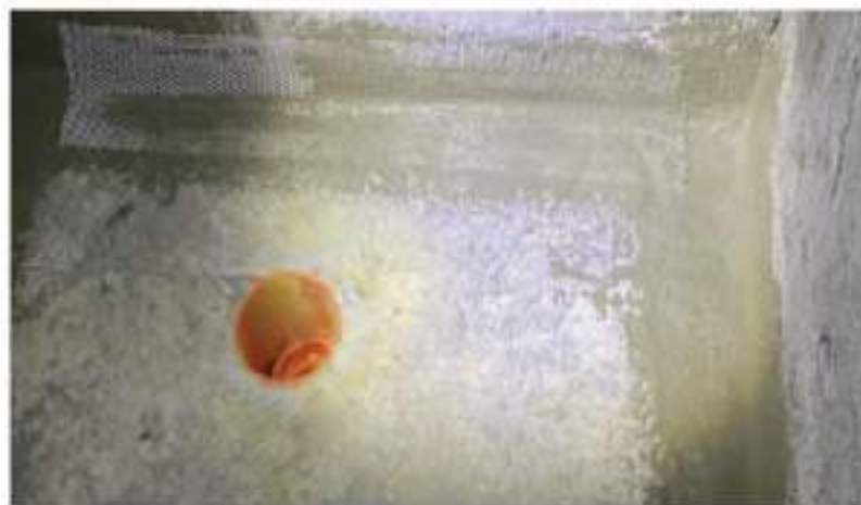
5. 彈泥第一度, 鋪抗裂網
