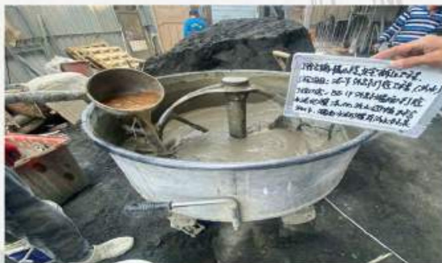
外牆打底 完成後噴塗防水彈泥施作
