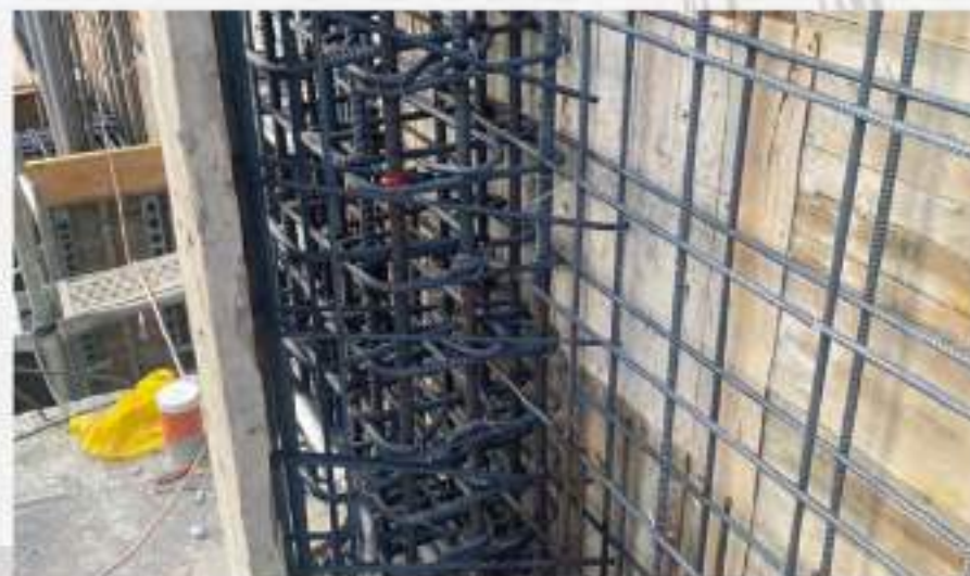
樑柱結構 續接器施工紮實
