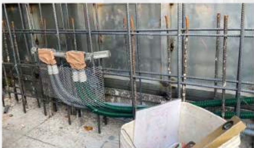
水電配管落實。
