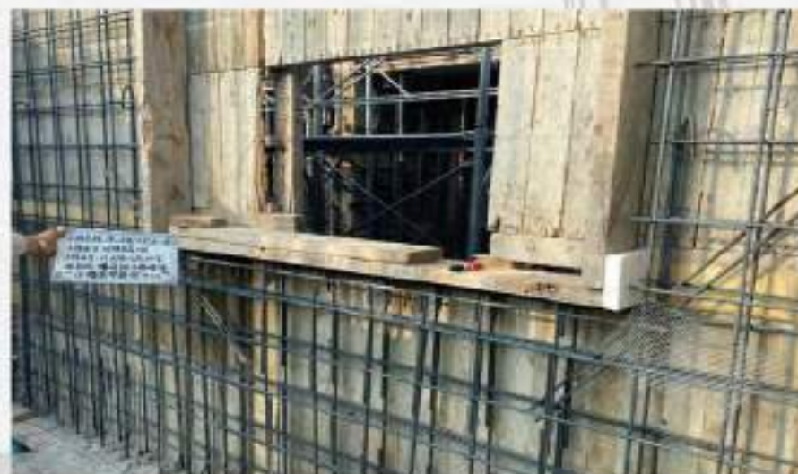
牆筋綁紮完成後鋼筋 自主檢查確保施工品質
