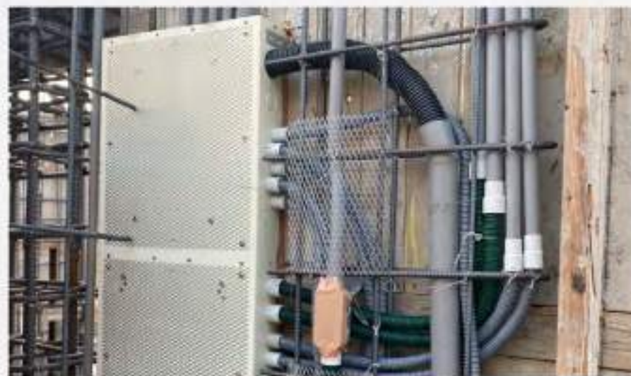
水電配管落實。
