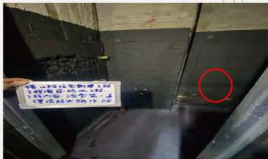
浴室防水浸水測試
