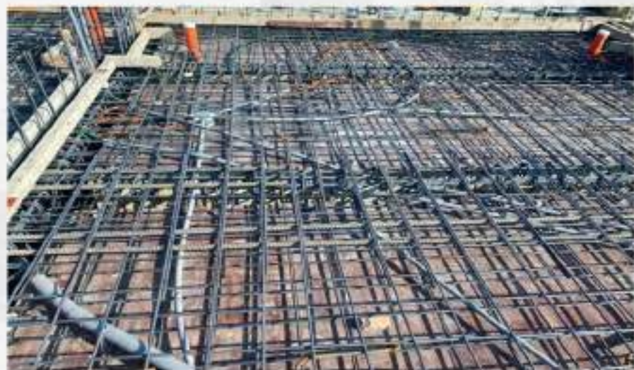
樑版筋綁紮完成
