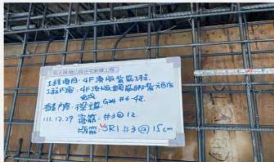
版筋綁紮完成後鋼筋 自主檢查確保施工品質
