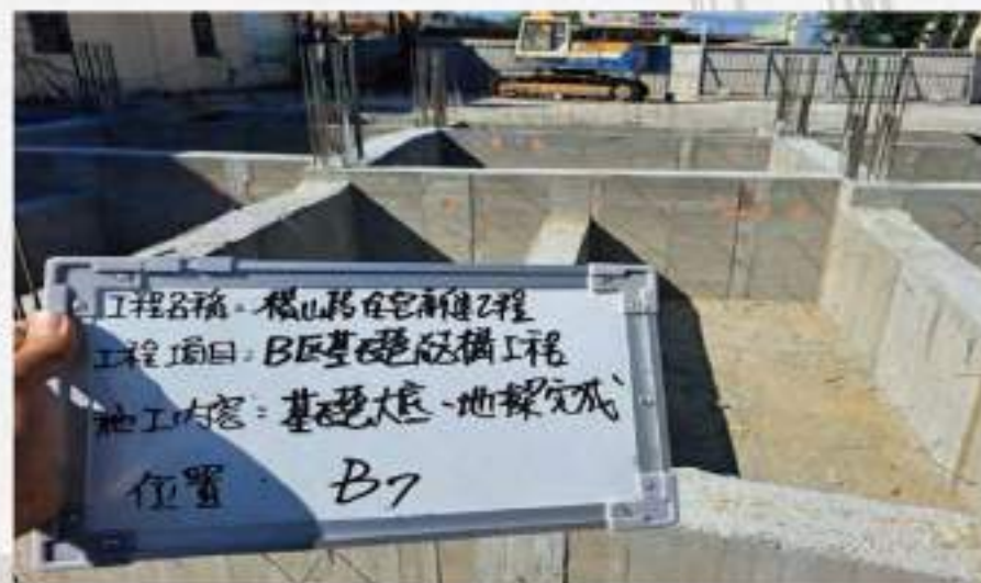
筏式基礎強度 245kg/cm 2 混凝土 澆置施作完成
