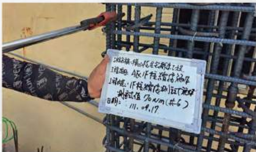
樑柱結構 續接器施工紮實
