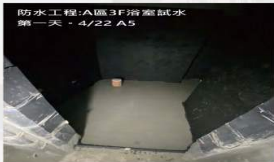
浴室防水浸水測試
